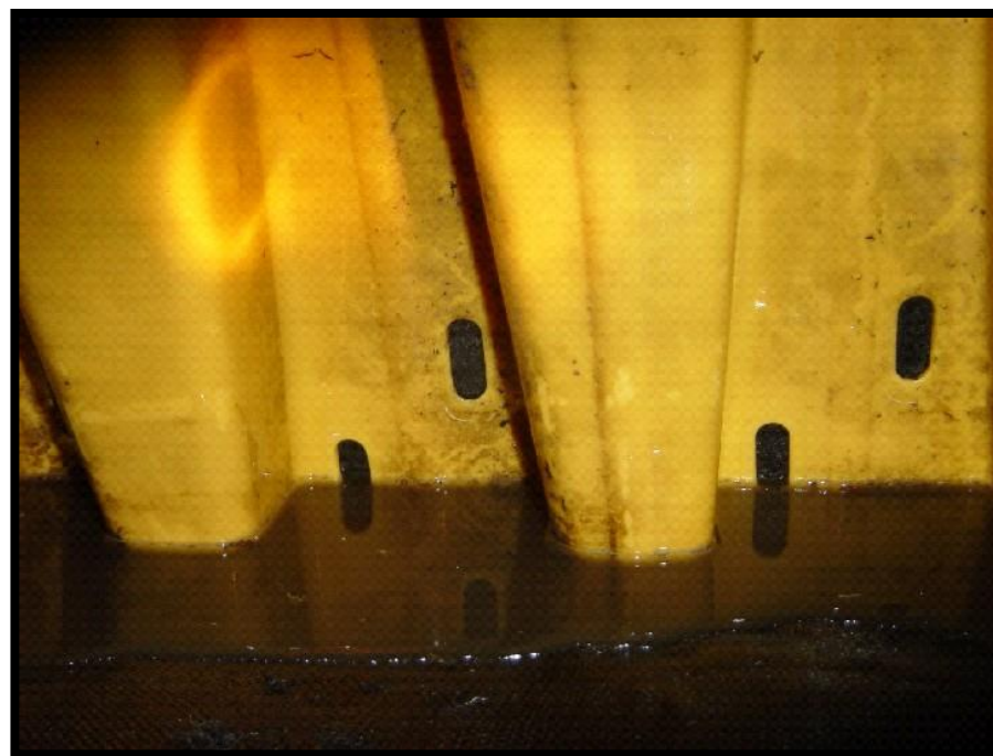
Posle čišćenja JET sistemom pod visokim pritiskom
